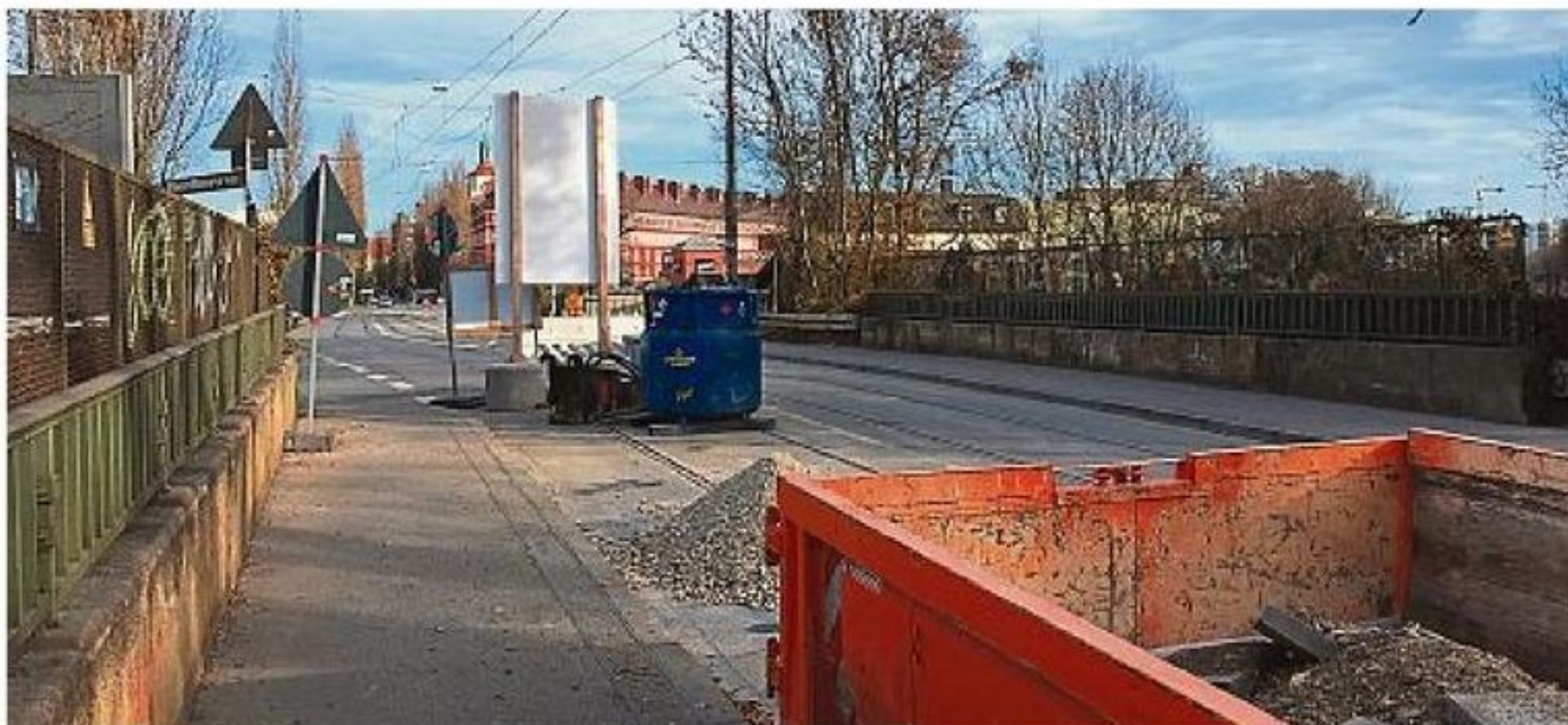
Gefahrenstelle für Fußgänger und Radler: die Regerbrücke, derzeit Baustelle wegen der Gleiserneuerung am Ostfriedhof.
