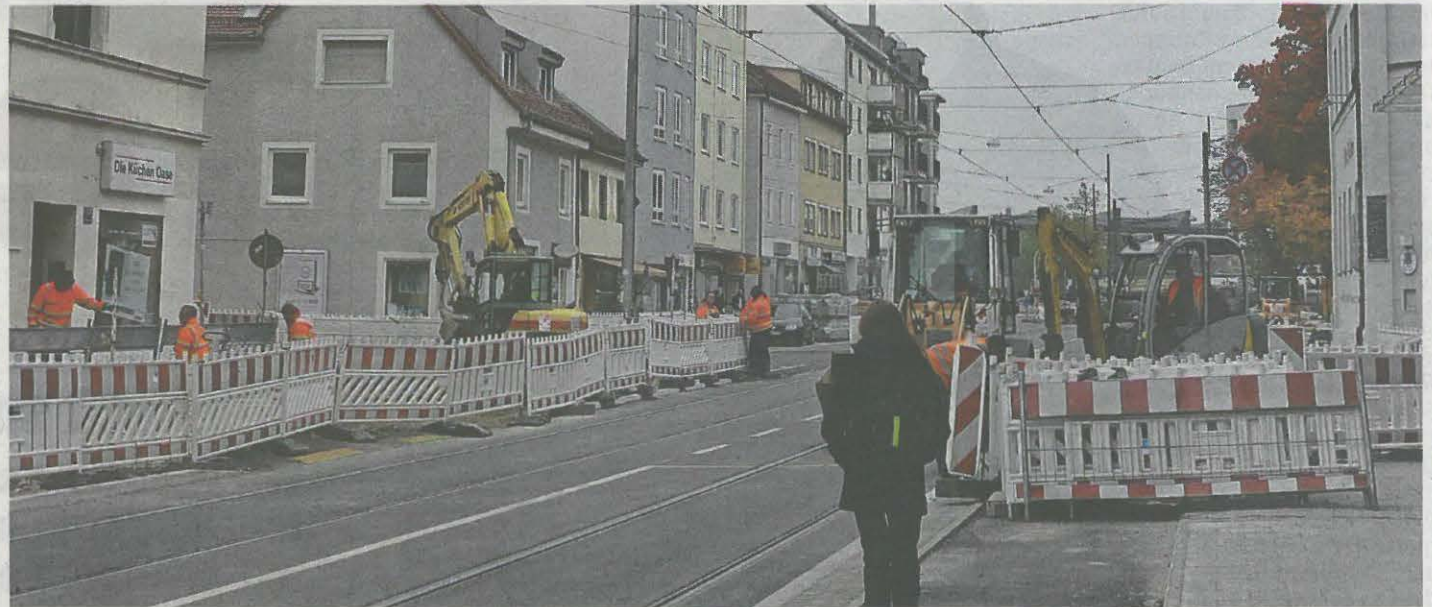
Blick von der Silberhornstraße aus auf die TeLa Richtung Norden - noch prägen Baumaßnahmen das Bild.
